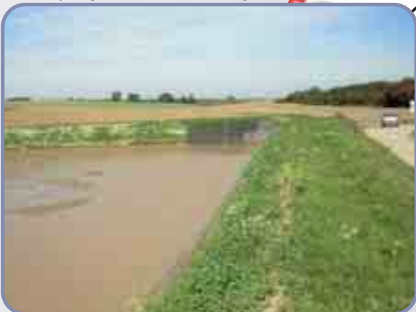
Opvangbekken vallei van Buvingen
